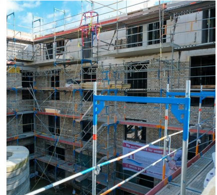
Der Richtkranz hängt und die Arbeiten gehen planmäßig weiter: das neue Seniorenzentrum Heimaadhaven. BILD: HASSELER
